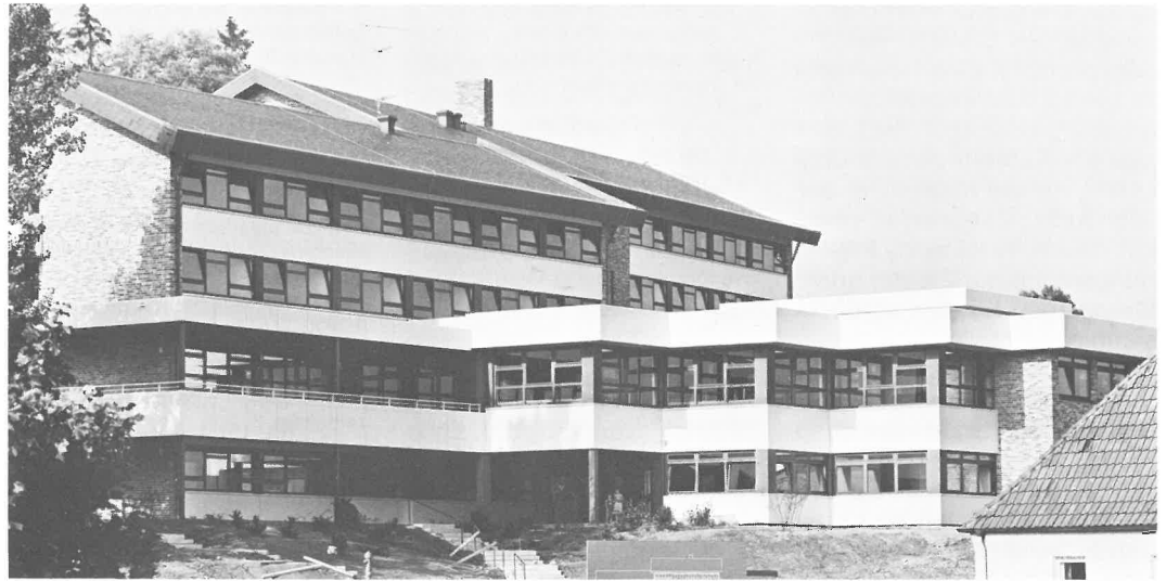
Außenansicht des mit einem Kostenaufwand von 8,5 Mio. DM errichteten Wohnheims in Waldkirchen
