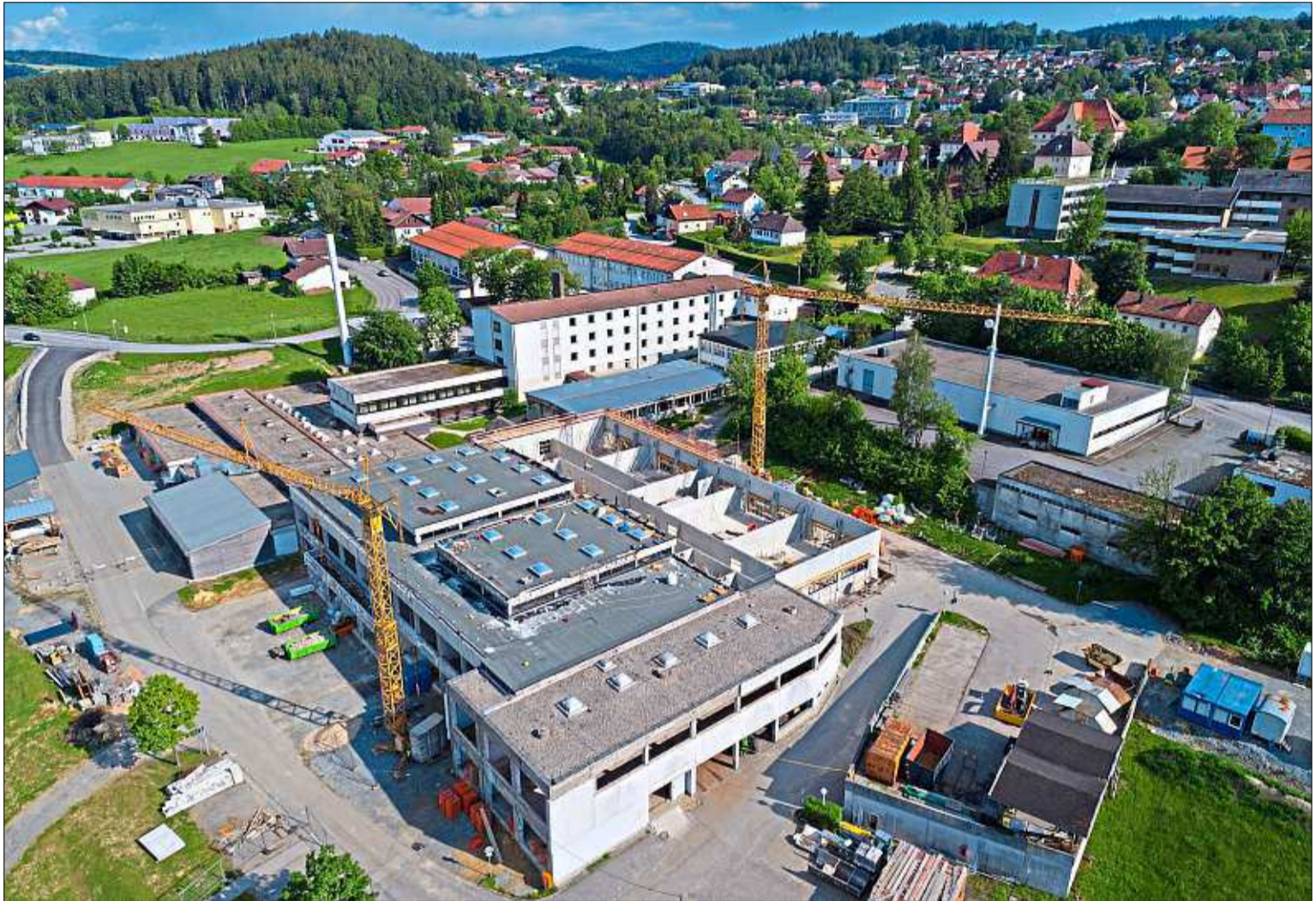
Die größte Baustelle des Landkreises aus der Vogelperspektive: Unser Luftbild zeigt die Arbeiten in diesem Sommer – unter anderem die Dachdeckerhalle stand dabei im Mittelpunkt. Hier präsentiert sie sich noch ohne Dach. – Foto: Hintermann
